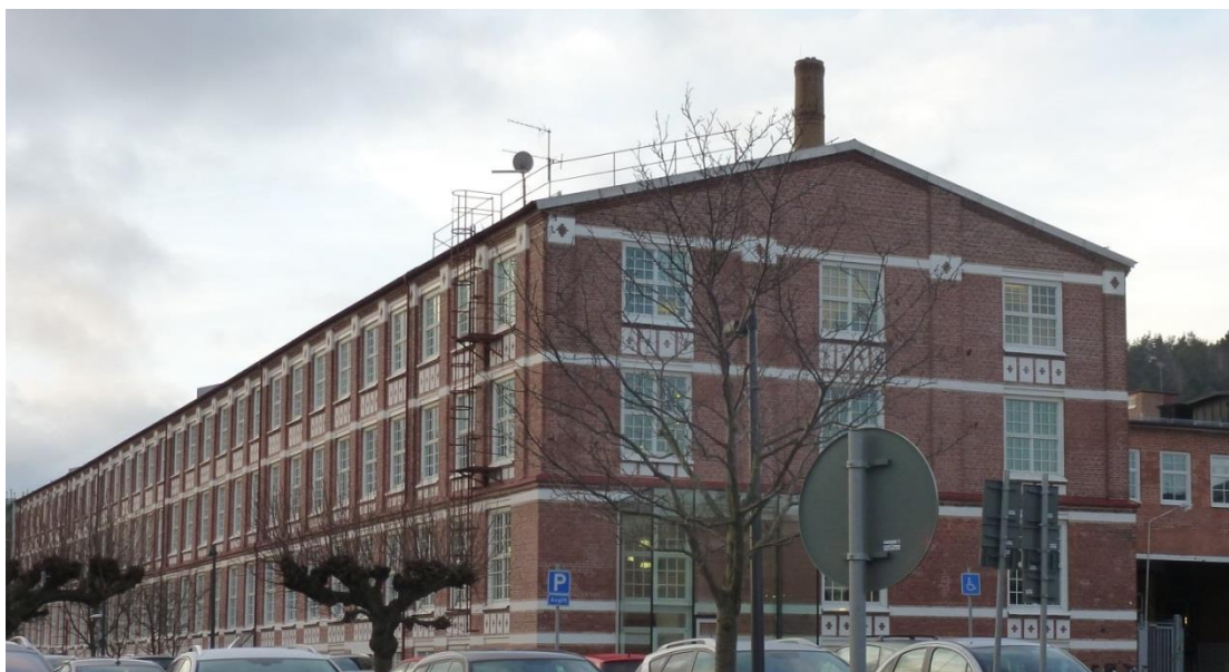
Figur 5. K-märkt byggnad vid Krokslätt's fabriker, Mölndal.
